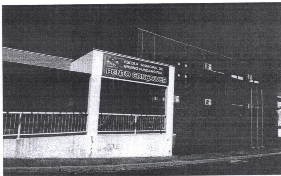
Revestimentos e acabamentos externos da Escola.
